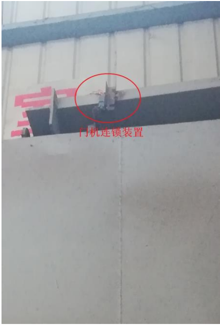
C 防护门门机连锁装置
